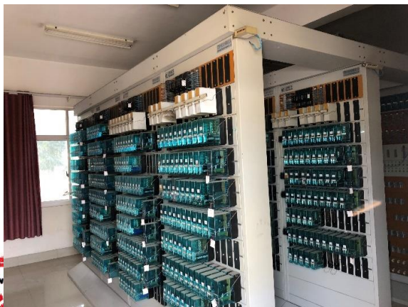
1. Bastidores de Sinalização a relé 2. Bastidores de Telecomunicação
