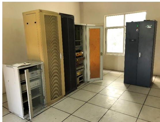
1. Bastidores de Sinalização a relé 2. Bastidores de Telecomunicação
